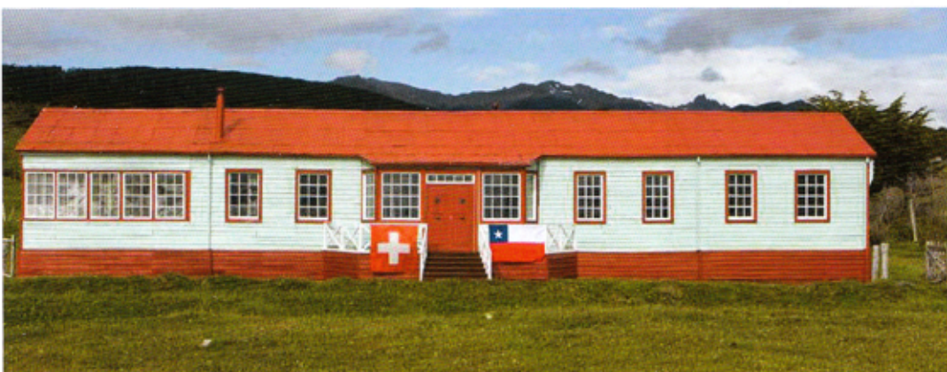
Bâtiment restauré. Typique de l'architecture coloniale de Patagonie. Les différents espaces naissent de la nécessité de se protéger du vent et du froid avec des matériaux que la nature offre sur place.
